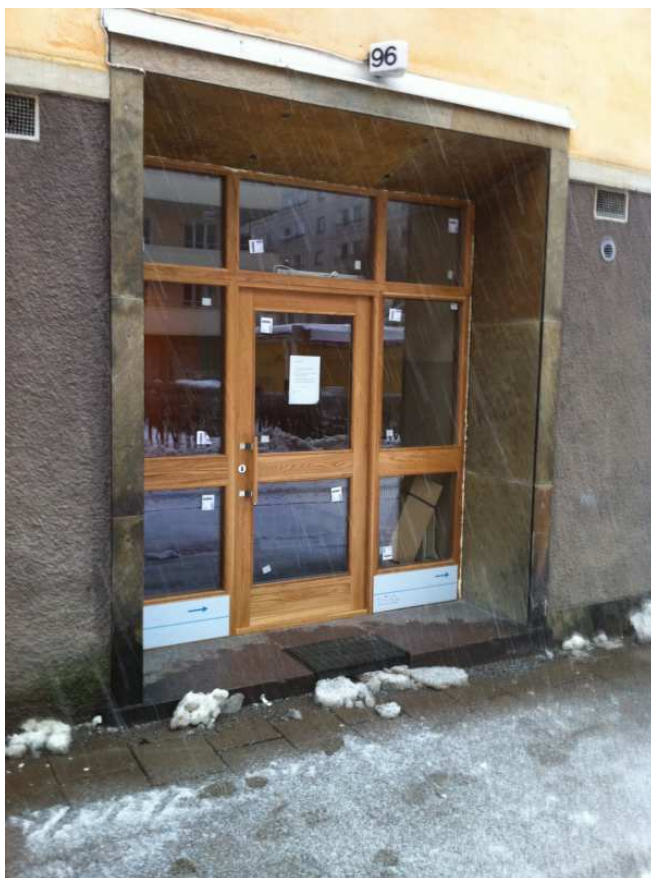
Under året har entréportarna byts ut till ek.
